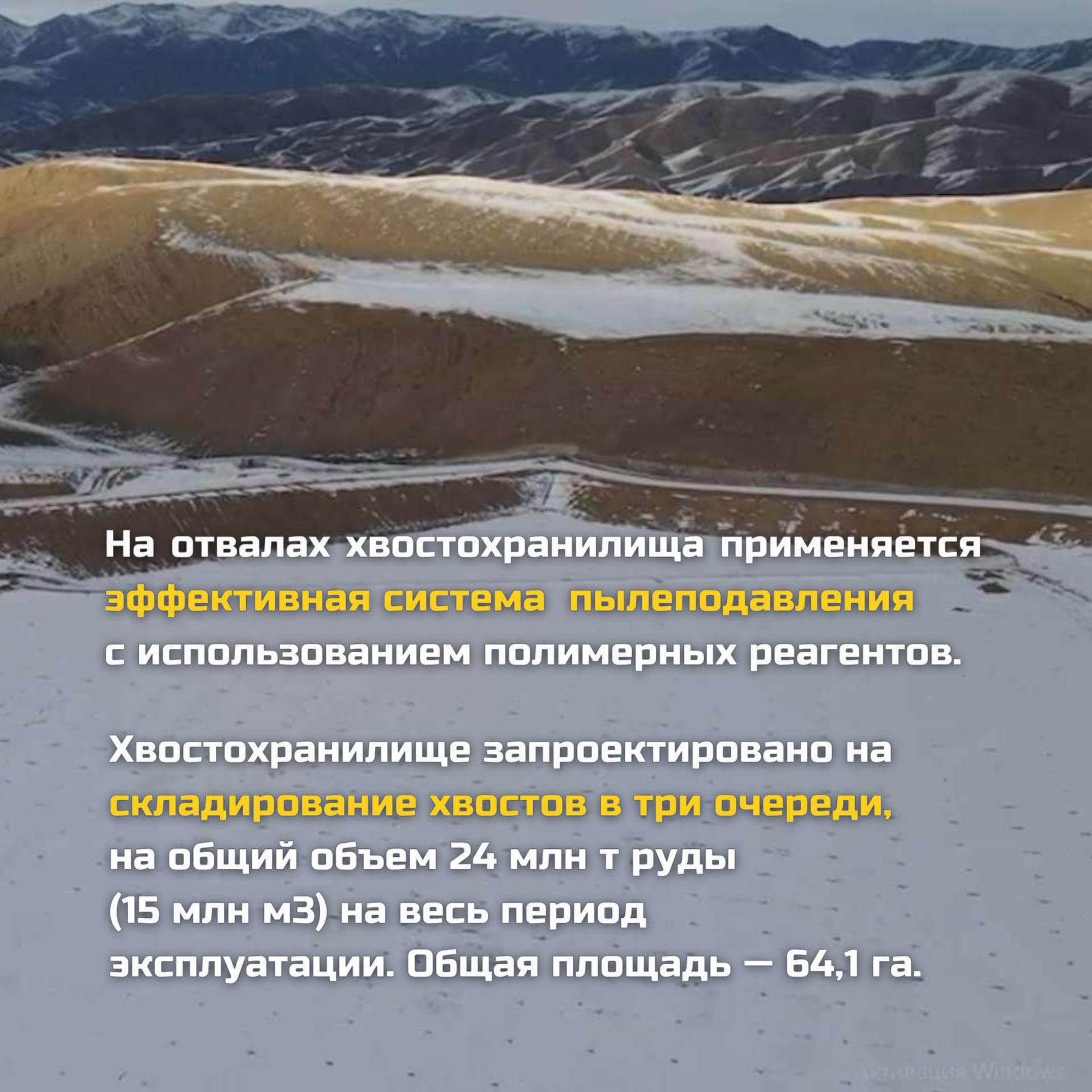
**На отвалах хвостохранилища применяется эффективная система пылеподавления с использованием полимерных реагентов.**
